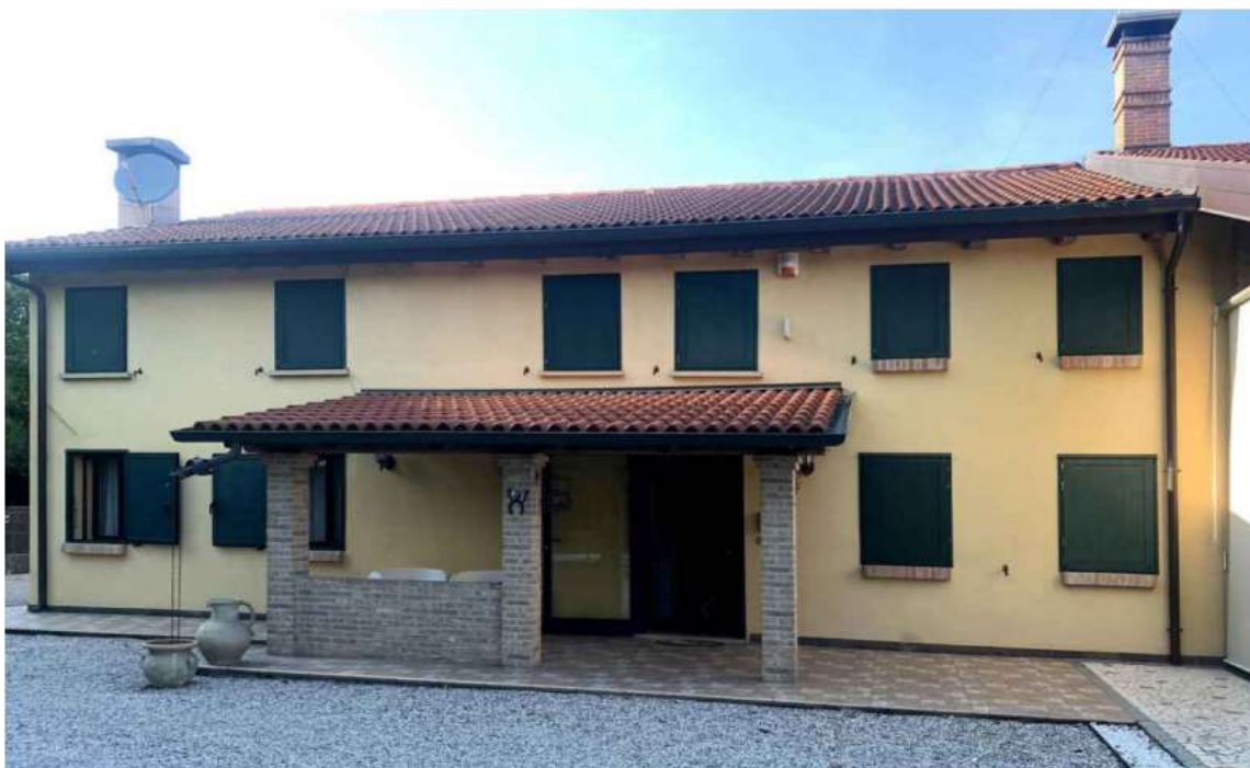
Fig. 3.6 - Vista edificio da demolire da sud.
