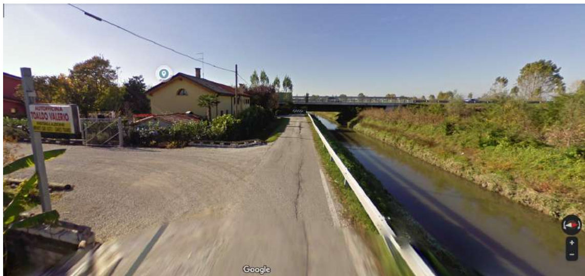
Fig. 3.5 - Vista ovest del contesto in cui è situato l'edificio da demolire e la relazione con la vicina strada SS308 e con il fiume Muson Vecchio (fonte google map).
