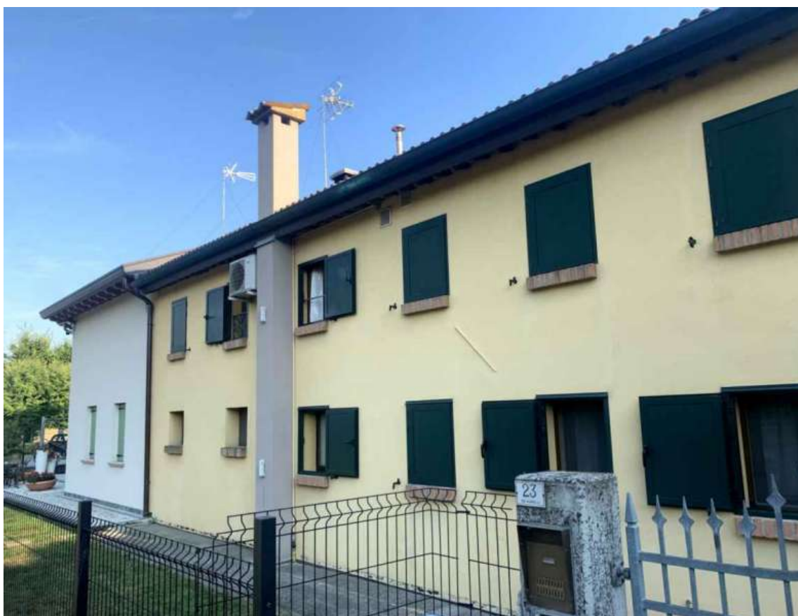
Fig. 3.7 - Vista edificio da demolire da nord.
